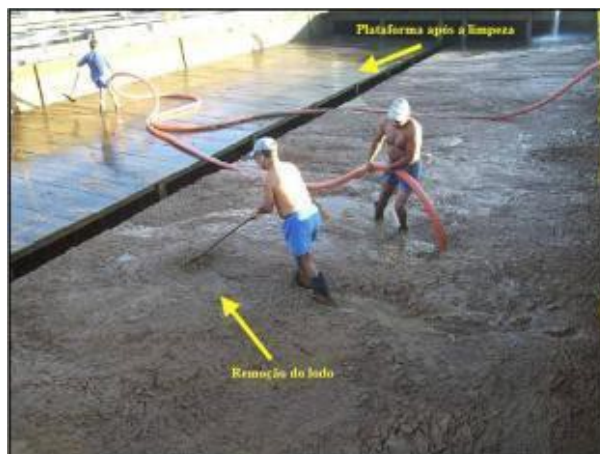
Figura 2. Funcionários removendo o lodo residual na ETA de Goiânia-GO
