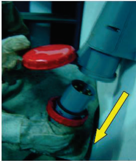
Fig. 44 – Desconectando equipamento Da Rede Elétrica
