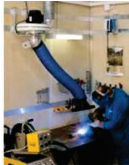
Fig. 9 – Sistema fixo de exaustão
